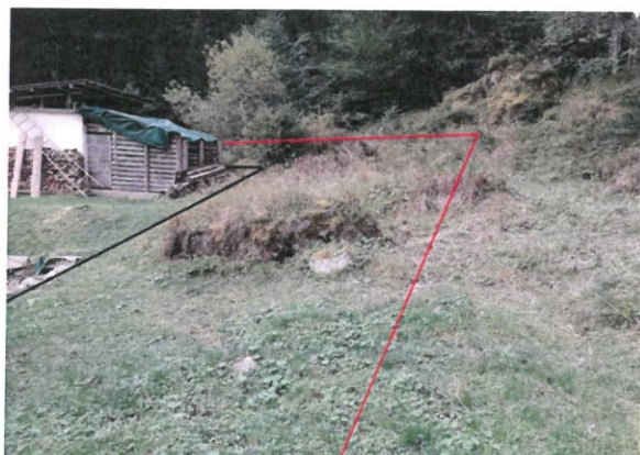
Identificazione p.f. 2018/6 lato S-E edificio
