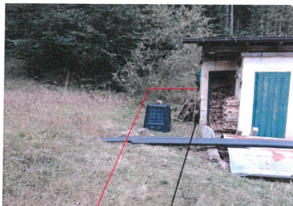
Identificazione p.f. 2018/6 lato N-E edificio
