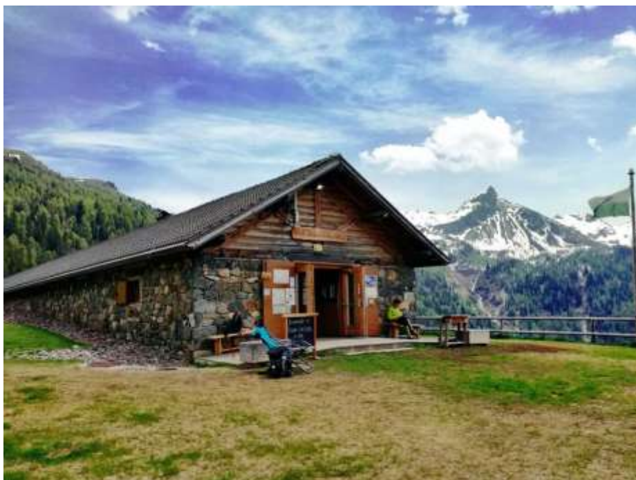
vista ingresso rifugio
