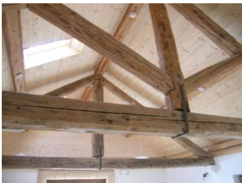
particolare tetto a vista nella sala bar-ristorante
